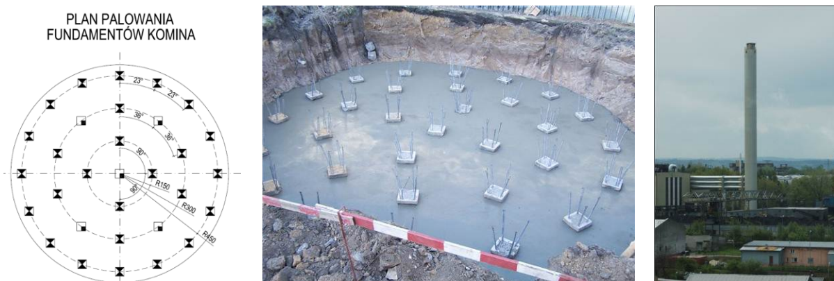
Rys. 9. Od lewej: plan palowania, widok fundamentu palowego, widok komin WSK w Rzeszowie (Archiwum Aarsleff Sp. z o.o.)
