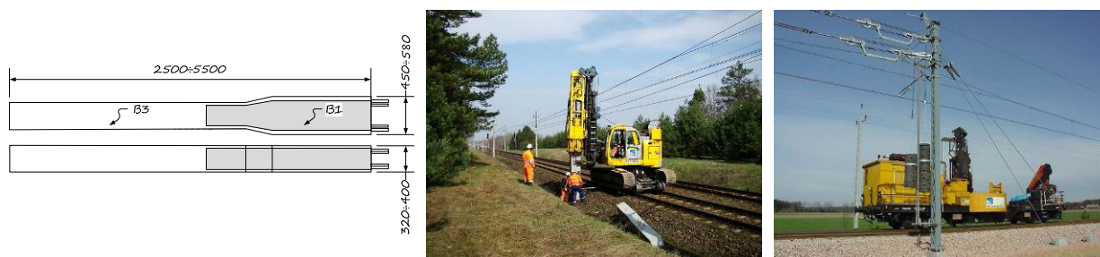
Rys. 4. Od lewej: prefabrykat fundamentu palowego, wbijanie pala oraz słup zmontowany na palu prefabrykowanym (Archiwum Aarsleff Sp. z o.o.)
