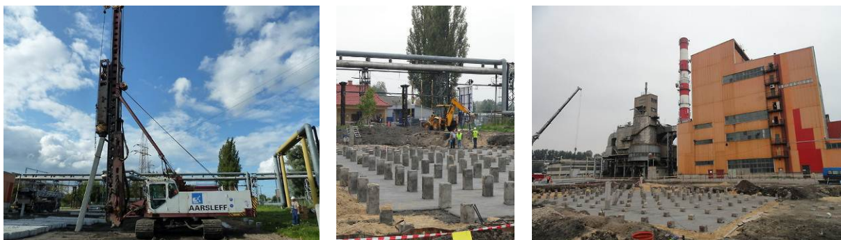
Rys. 8. Fundament palowy bloku energetycznego w Elblągu (od lewej): wbijanie pali, wbite pale i istniejące obiekty elektrowni w bezpośrednim sąsiedztwie terenu robót fundamentowych (Archiwum Aarsleff Sp. z o.o.)
