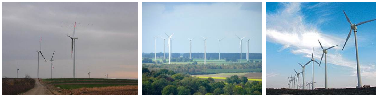
Rys. 6. Przykłady farm wiatrowych posadowionych na żelbetowych palach prefabrykowanych wbijanych (od lewej): Orzechowce, Karściono i Margonin (Archiwum Aarsleff Sp. z o.o.)
