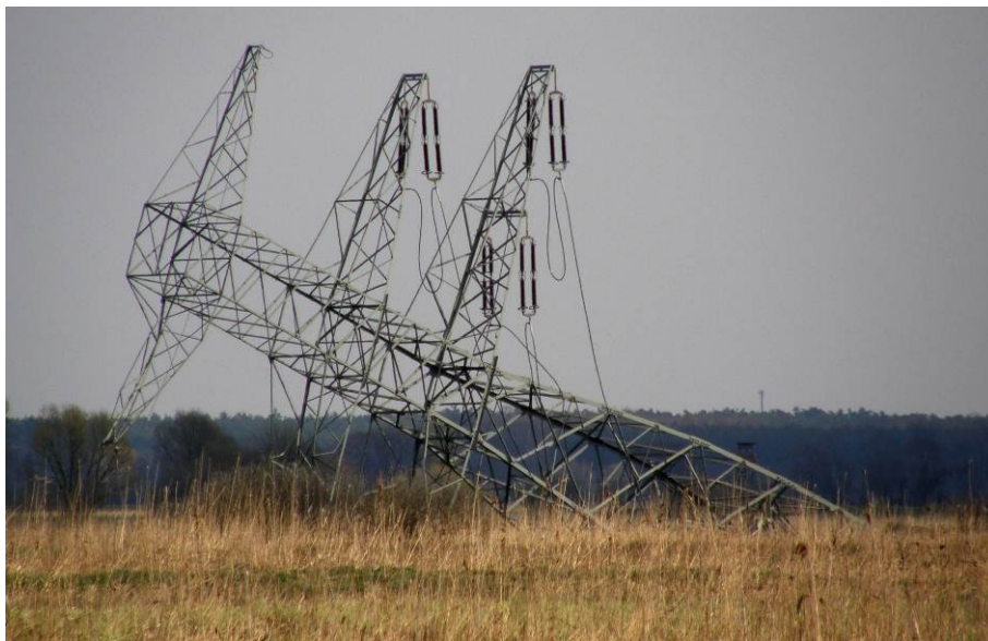
Rys.3. Przykład awarii słupa energetycznego w okolicy Szczecina – kwiecień 2008 (Autor: 7alaskan)
