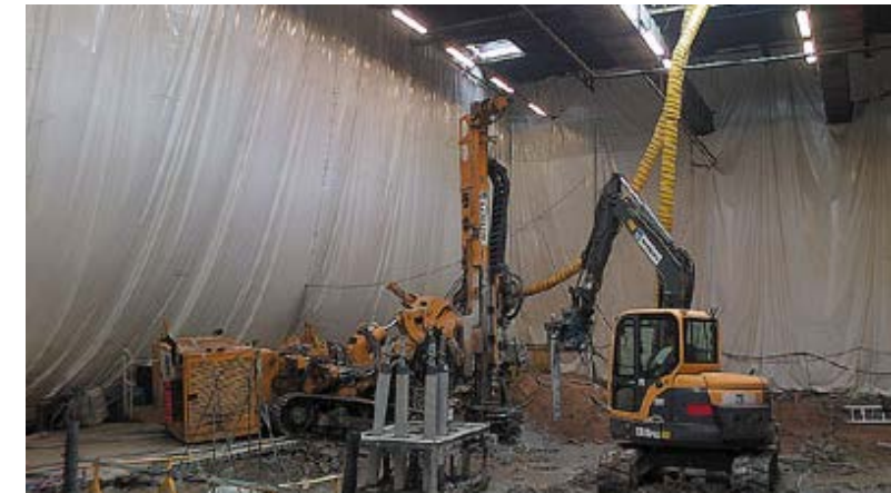
Wiertnica Klemm wewnątrz hali (widoczny system odprowadzenia spalin) – Olsztyn
