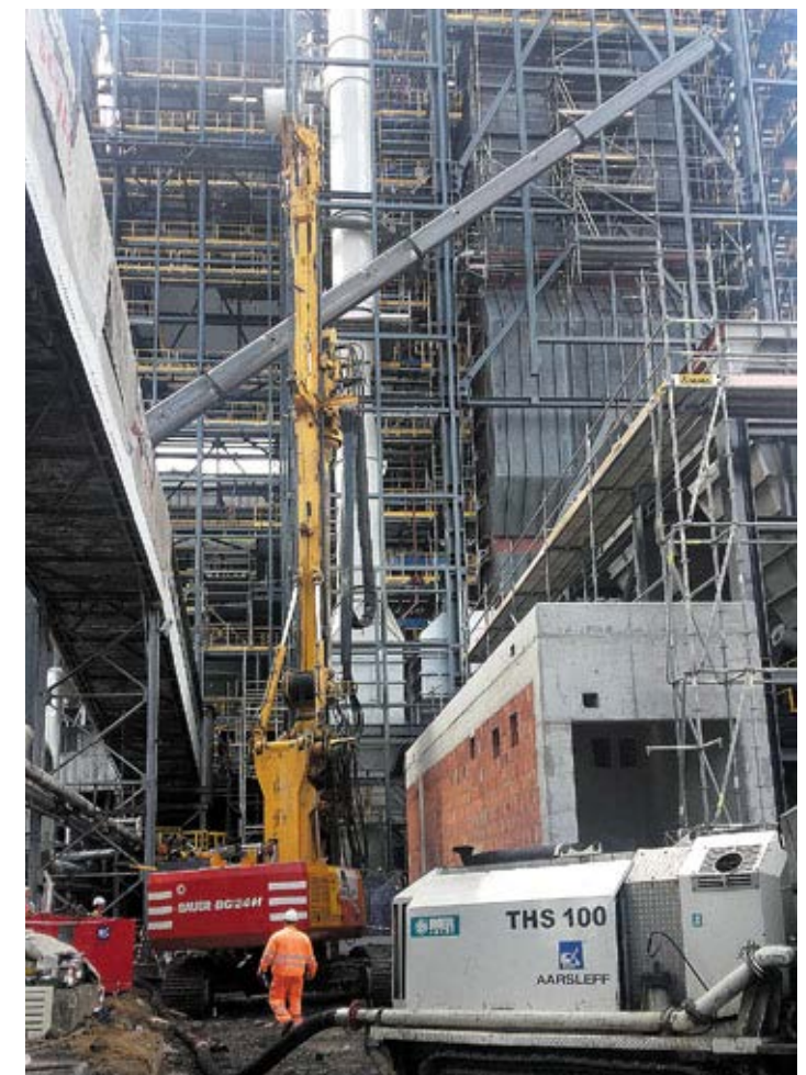
Wykonanie pali FDP w warunkach trudnego dostępu – Jastrzębie-Zdrój
